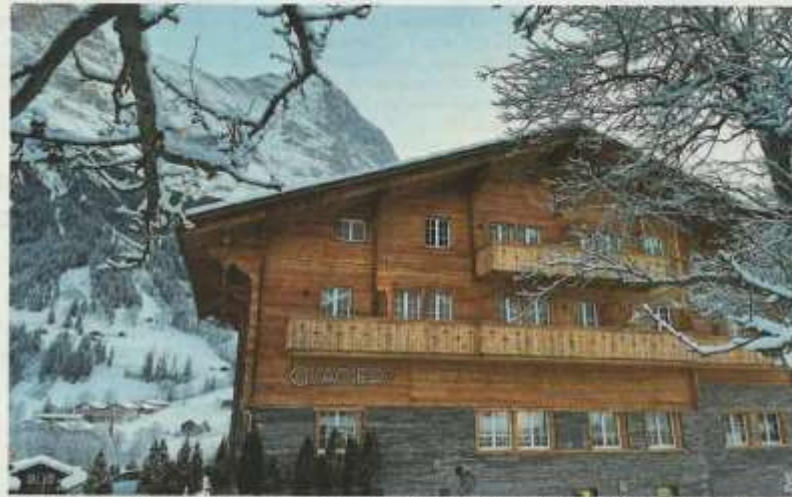
Oben: Das Holz im Hotel Jufa in Savognin stammt aus den umliegenden Wäldern. Unten: Das Hotel Glacier in Grindelwald fügt sich durch den Chaletstil ins Ortsbild ein.
