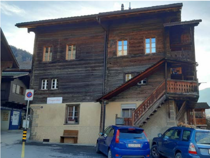
Abbildung 1 Ansicht von Parkplatz
